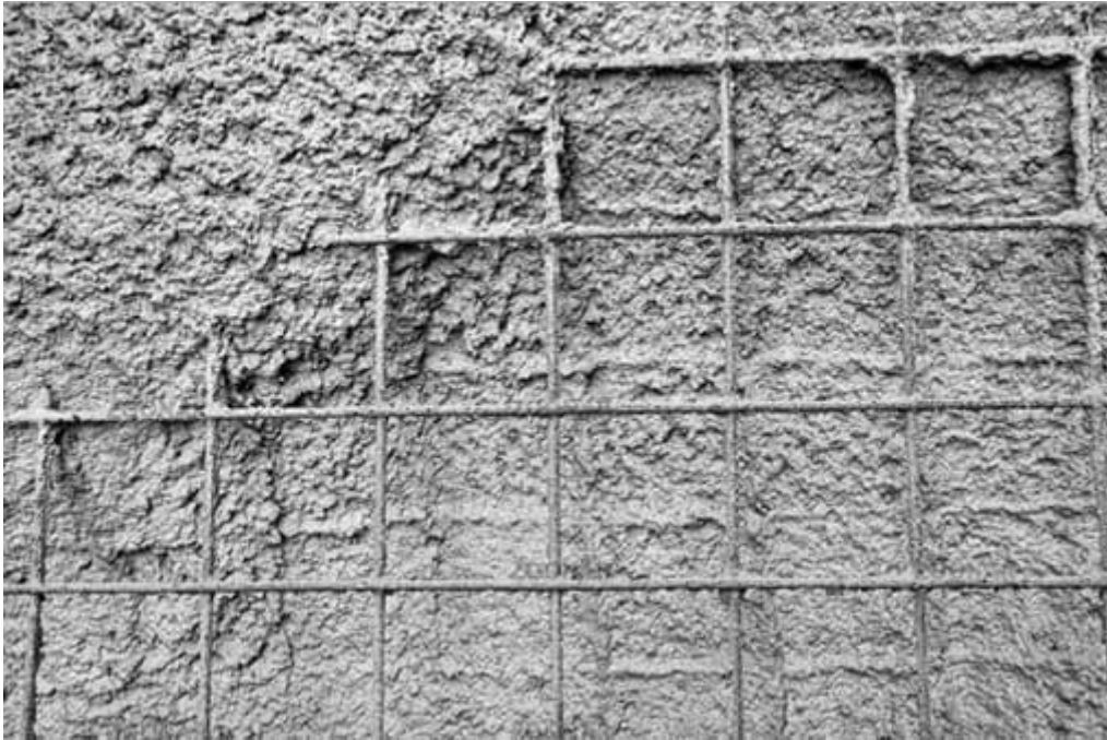
Figura 10 Armadura metálica de painel de concreto armado. Fonte:AECWeb. Concreto armado é solução durável e econômica. São Paulo: Ed. Projeto, 2014. Disponível em: < https://www.aecweb.com.br/cont/m/rev/concreto-armado-e-solucao-duravel-e-economica_6993_0_1 >. Acesso em: 16 fev. 2019.
